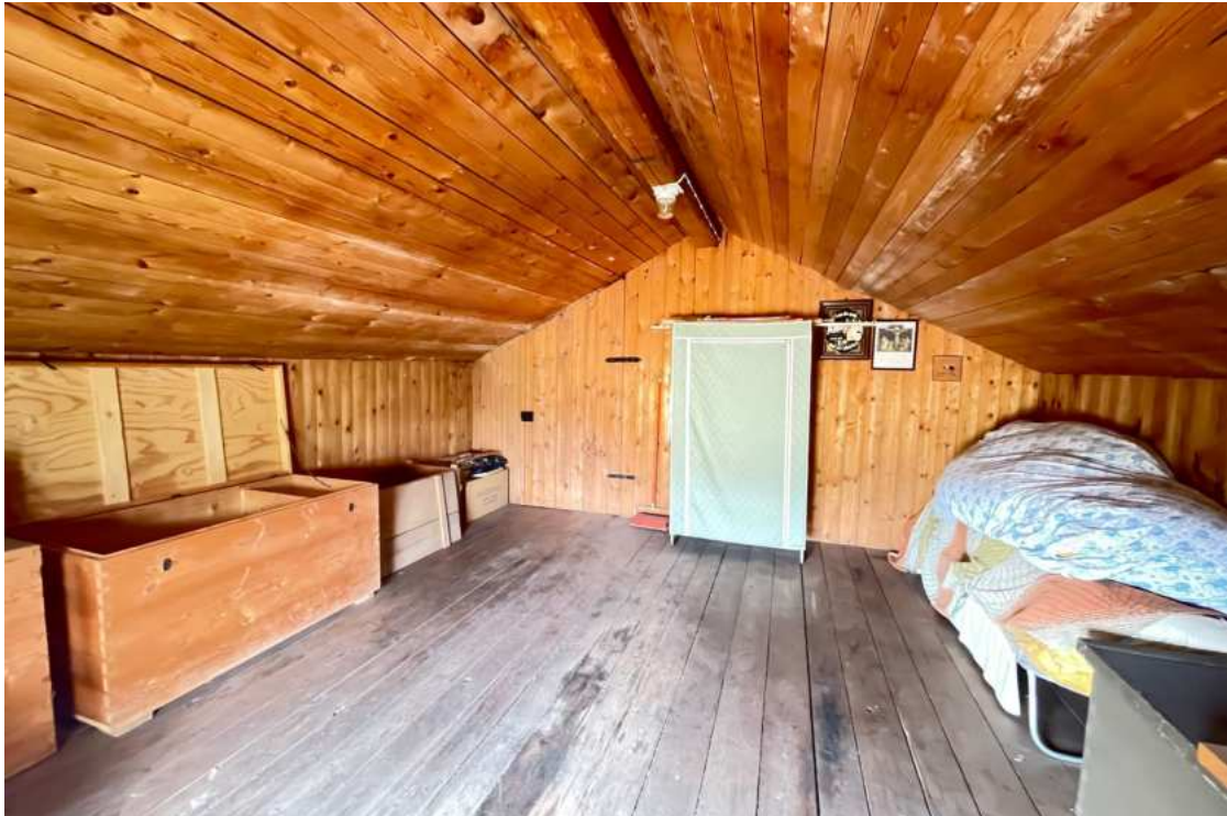
Weiterer Abteil des unausgebauten Dachbodens
